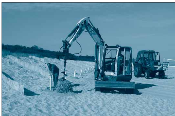
Die Drahtabspannung an Strandaufgängen und Dünenfuß wird angebracht.
