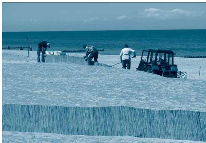
Sandfangmatten werden sturmsicher aufgestellt
