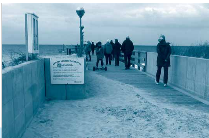
Versandete Seebrücke nach einem Sturm
