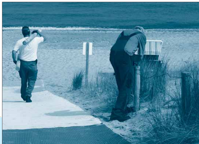
Aufstellen der Absperrungen
